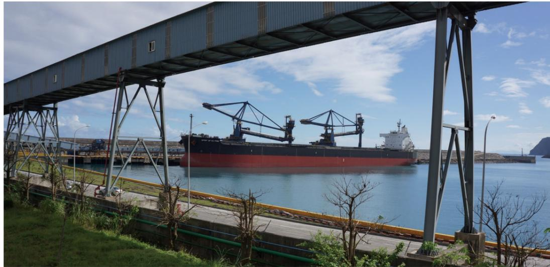
設置水泥專用碼頭、卸煤碼頭及多用途碼頭等四座，可作為 8 萬噸級以下船舶進出口裝卸之用，總吞吐量達 2,300 萬噸。提供和平專業區內各廠商使用，可降低運輸成本，增加市場競爭力。和平專用港環保經費耗資近千萬元，購買洗潔船負責港區水域漂流物及垃圾之清理工作，分區進行港區植栽綠化工程，以達「綠化港」之目標。港區儲運系統係採密閉式廊道輸送帶設計以減少物料粉塵溢散，碼頭則設置自動裝卸料機具降低港區貨運流量，減少空氣污染。
