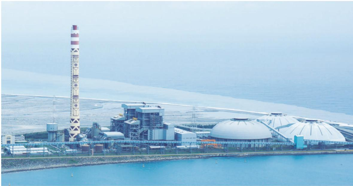
配置兩組 660MW 裝置容量燃煤汽力發電機組，採用密閉式燃煤儲運系統、靜電集塵器、排煙脫硫設備、選擇性觸媒轉化器脫硝設備、低氮氧化物燃燒器及自動連續監測系統等多項最先進之空氣汙染防治設備，有效控制煙囪排放硫氯化物及氮氧化物之濃度，達國內法規高標準之門檻。
