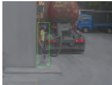
AI影像辨識 發現人員未配戴安全帽且未穿著反光背心，立即發出警示
