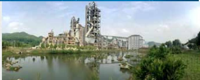
台泥集团废弃物协同处理项目，涵盖生活垃圾、市政污泥及固体危险废物三个领域，充分利用水泥窑 1,300 度高温特性，可彻底分解废弃物中有毒物质，避免二噁英的产生。加上水泥窑高扰流、高滞留时间的特性，可妥善处理废弃物；处理后的废弃物可再次成为水泥制程的原料，将资源利用最大化，减少资源的耗用，实现“无废城市”与循环经济的理念，达到“资源、减量、无害”的目标。
