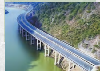
武靖高速公路-湖南
