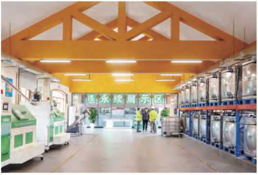
英德厂厨余处理中心
