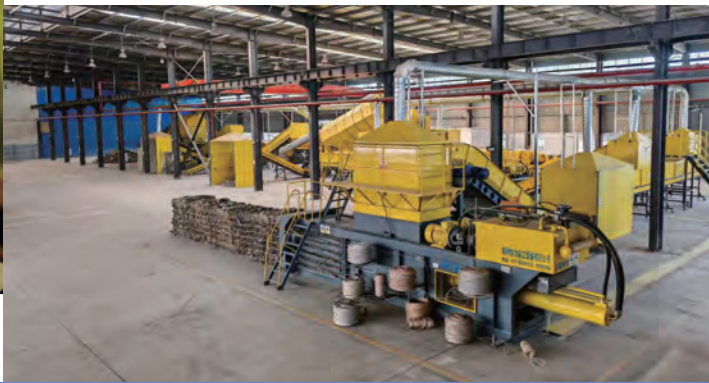
↓ 重庆晒洁台泥环保科技有限公司2023年12月投产处理工业废标签破碎料
