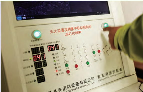
↑ 因替代燃料易燃特性，重庆厂导入无人智能温感灭火装置完整覆盖仓库，确保安全生产
