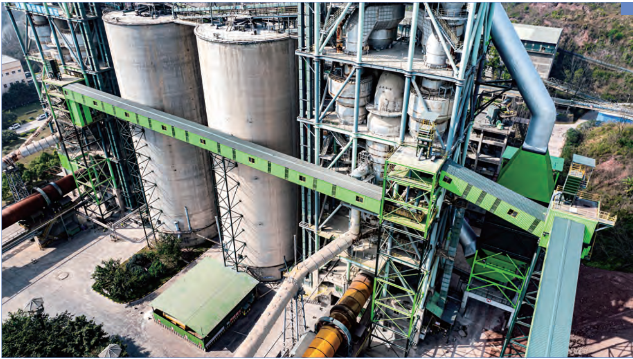
↑ 重庆厂替代燃料通道
