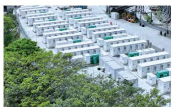
▲由NHOA負責案場規劃設計、台泥儲能負責建置之花蓮和平100MW、宜蘭蘇澳35MW增強型動態調頻備轉(E-dReg)儲能案場，分別於2023年12月及2024年4月上線台電力交易平台，每天可調節台電北東電網200MWh離尖峰用電。台泥儲能與NHOA義大利團隊合作，學習案場建置與調控，NHOA亦從中了解台灣電力規範、系統需求、電路設計，實現1+1>2的綜效。
